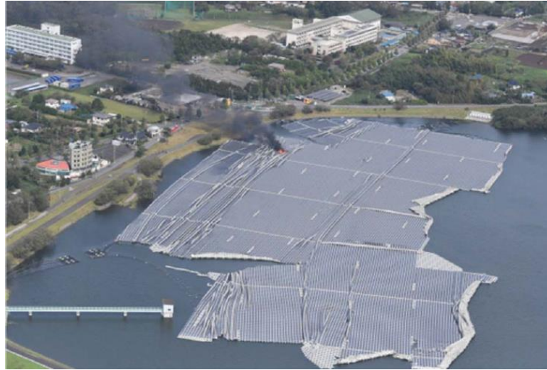
Effet du vent sur l'installation photovoltaïque flottante de Yamakura FPV au Japon (source : https://www.hydropower-dams.com )
